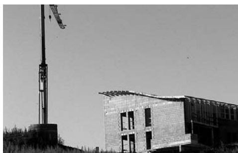
Le logement doit être soutenu
