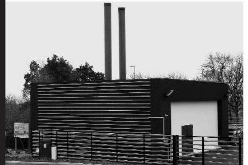
Chaufferie : un emplacement discutable
