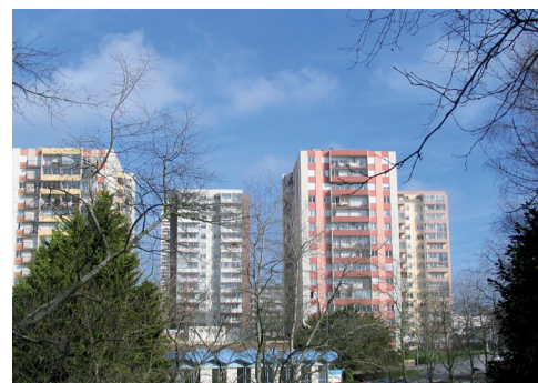
Plus de 7 millions de logements à rénover
