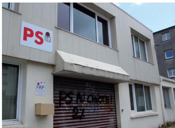
Des dégradations inacceptables
