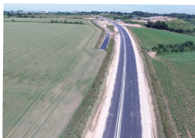
Les routes départementales vecteurs indispensables du développement du Finistère
